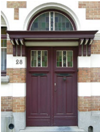
Geveldetail, Schermstraat 28. Arch. François Van Meulecom, 1925. (foto van de auteur)
