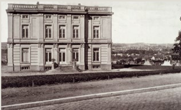
Het kasteel Zaman in de Domeinlaan, gesloopt in 1948.
