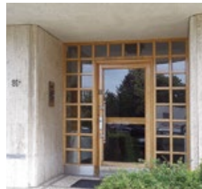
Ingang van het appartementsgebouw Duden Horizon, Jupiterlaan 91A. Arch. Roger Dejenef en Joseph Thomas, 1952. (foto van de auteur)
