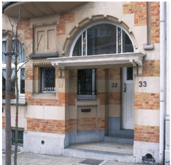
Geveldetail, V. Rousseaulaan 33. Arch. François Van Meulecom, 1923. (foto P. De Goibert ©AAM)
