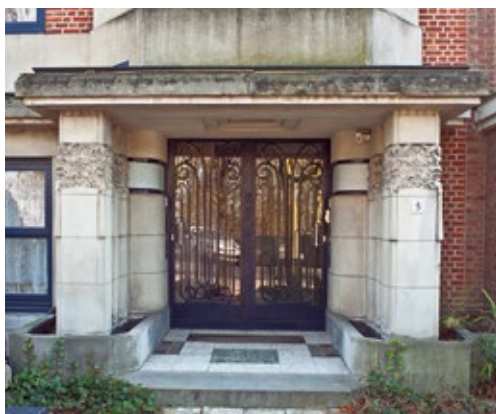
Detail van het portiek van de eigen woning van architect Willem Vermeiren, 1934. (foto A. de Ville de Goyet © GOB)
